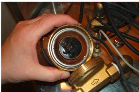
Теперь внутри насоса видна крыльчатка. Осторожно: крыльчатка насоса может выпасть! Повреждение пластин крыльчатки приведет к последующему отказу насоса!
