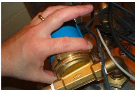
Теперь нужно вымыть насос. Откройте насос. Корпус насоса должен открываться вручную. Если это не так, ослабьте накидную гайку с помощью бруска и молотка.
