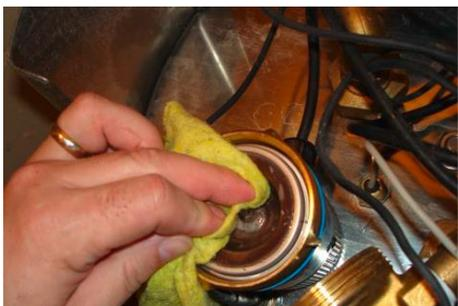
Корпус насоса также следует промыть. Затем вставьте вымытую крыльчатку насоса обратно в корпус. **Наконец, затяните резьбовое кольцо насоса, но только вручную.**
